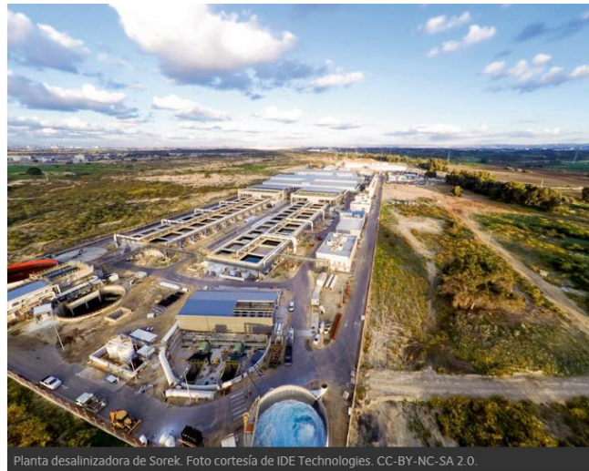
Planta desalinizadora de Sorek. Foto cortesía de IDE Technologies. CC-BY-NC-SA 2.0.
